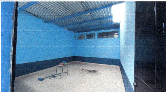
Foto 9: Aula 2 del módulo 4. Piso cerámico instalado y paredes pintadas.
