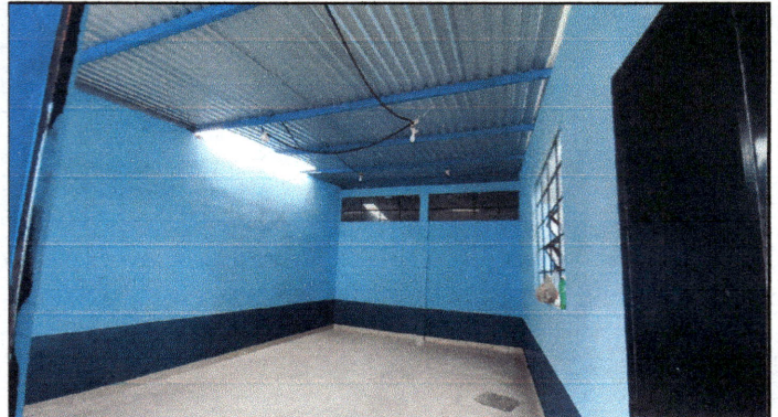
Foto 8: Aula 1 del módulo 4. Se observa piso cerámico instalado y paredes pintadas.
