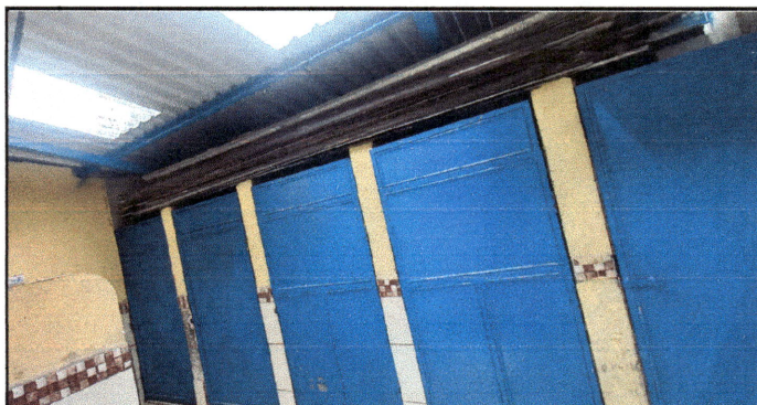
Foto 4: Módulo Baños, estructura de metálica y cubierta de lámina completamente sustituida
