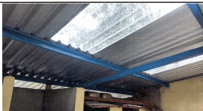
Foto 3: Módulo Baños, estructura de metálica y cubierta de lámina completamente sustituida
