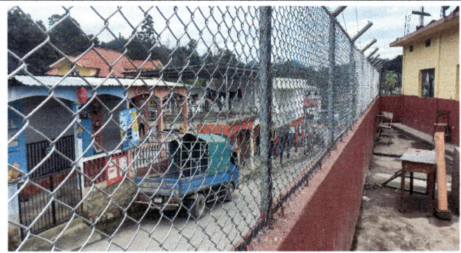
Foto 10: Muro perimetral. Se observa malla nueva instalada en muro perimetral.
